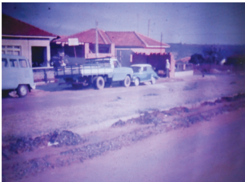
Ampliação da rede de água
